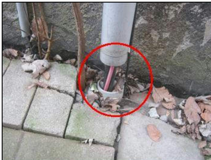
9. Conduit damaged
